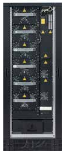
PU internal view
